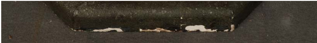
Fig. 11: Detalle de la Imagen. Pie derecho. Añadidos de soporte en la última restauración.
