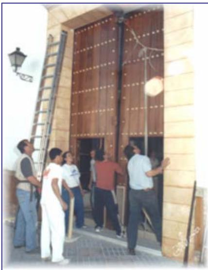
grúa retiró cada hoja de la puerta (bien sujeta con cuerdas). A continuación se colocó la nueva vigueta en la parte superior y se fijaron en el suelo los nuevos rodamientos. Provisionalmente y hasta que se pudo poner la nueva puerta se colocó una chapa.
